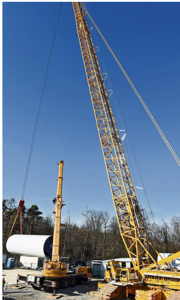
Die einzelnen Teile wurden zur Baustelle gebracht. Das Aufstellen der Segmente soll heute erfolgen
